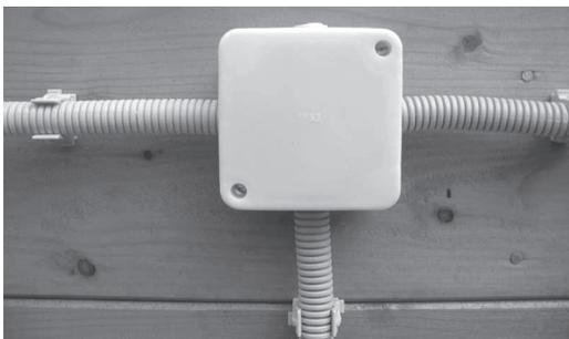
*Рис. 4.22. Монтаж с использованием гофрированных трубок*
