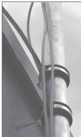
*Рис. 6.8. Штанга телевизионной антенны, подключенная к контуру молниезащиты*
