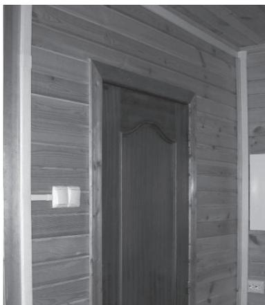
Рис. 4.24. Проводка в кабель-каналах
