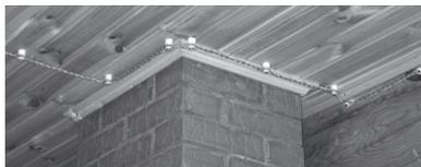
Рис. 4.17. Потолочная проводка на керамических роликах
